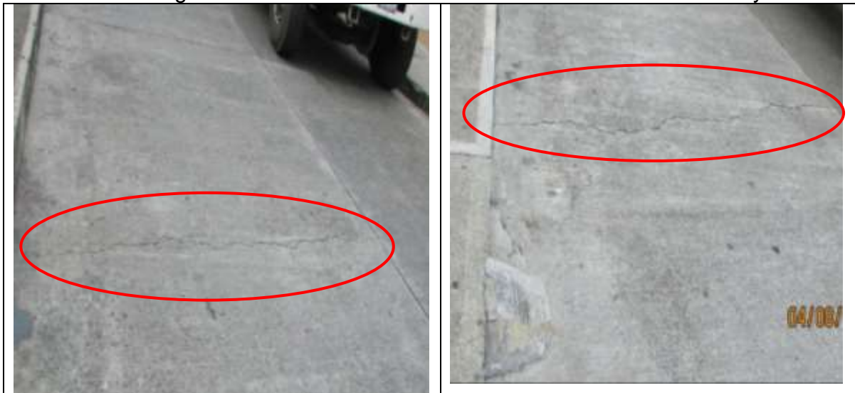
Vista de agrietamiento transversal en la calle 12 entre carreras 4 A y 5:
