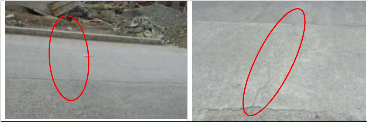
Vista de agrietamiento transversal (GT) en la carrera 11A entre calles 7 y 8:
