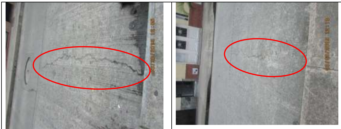
Vista de agrietamiento transversal (GT) en la carrera 6 entre calles 7 y 8:
