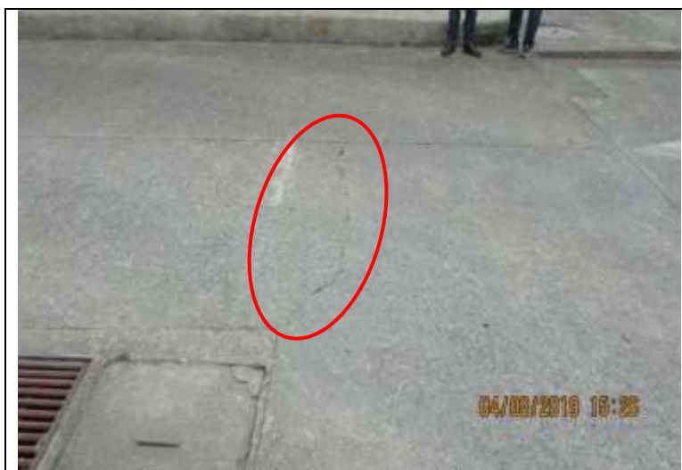
Vista de agrietamiento transversal (GT) en la calle 19 entre 7 y 7 A:
