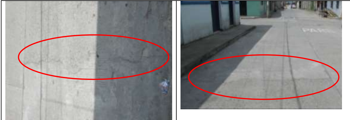
Vista de agrietamiento transversal (GT) en la calle 5 entre carrera 8 y 9:
