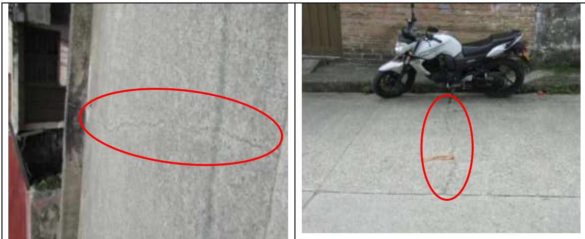
Vista de agrietamiento transversal (GT) en la calle 5 entre carrera 8 y 9:
