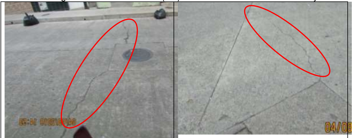
Vista de agrietamiento transversal (GT) en la carrera 11A entre calles 7 y 8:
