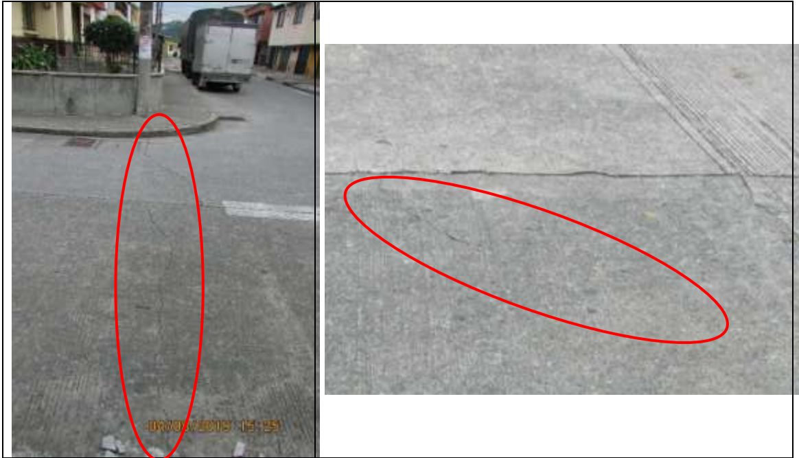
Vista de agrietamiento transversal en la calle 12 entre carreras 4 A y 5:
