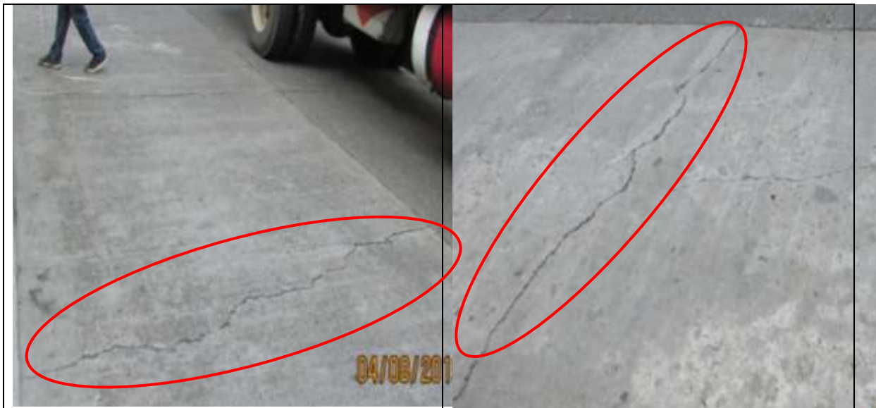
Vista de agrietamiento transversal (GT) en la calle 19 entre 7 y 7 A:
