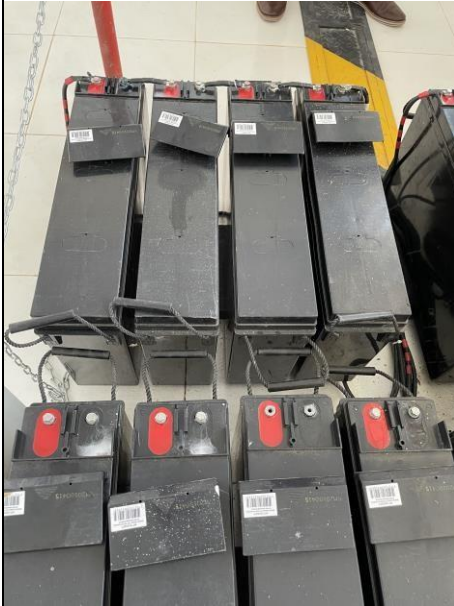
Imagen 3: baterías de AGM selladas de 200 AH/12V – puertos colmatados
