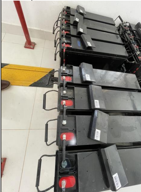
Imagen 3: baterías de AGM selladas de 200 AH/12V – puertos colmatados
