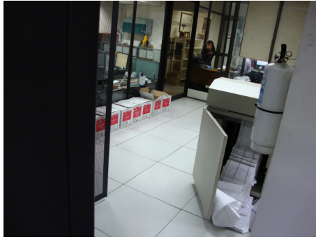
Foto 5. Centro de cómputo.
