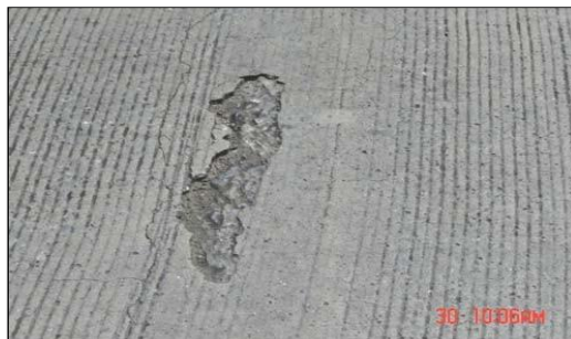
Vista típica de un descascaramiento.
