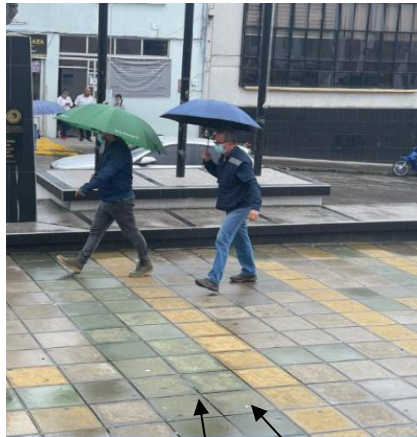
Ilustración 3: Loseta prefabricada en concreto 40 x 40 medida
