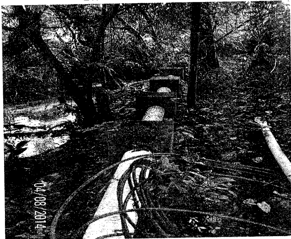
Foto N° 3. Tramo final de vertimiento de alcantarillado sanitario de La 4.
