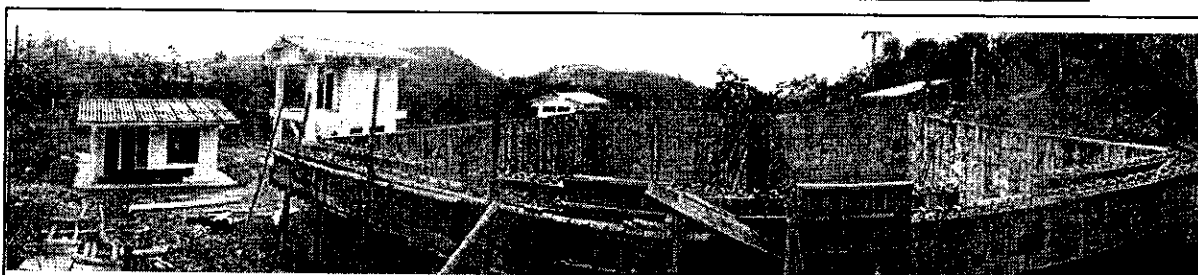
Fotografía Macroacueducto Villagarzón tomada el 18 de Marzo de 2014, se evidencia la construcción del tanque de Almacenamiento, La planta de tratamiento y las casetas de almacenamiento y de control del acueducto.
