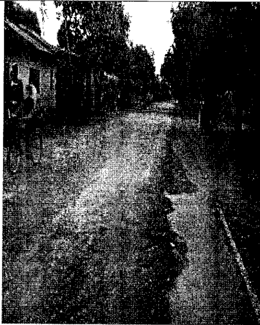
Imagen 17. Mala calidad en borde de vía al momento de la imprimación.
