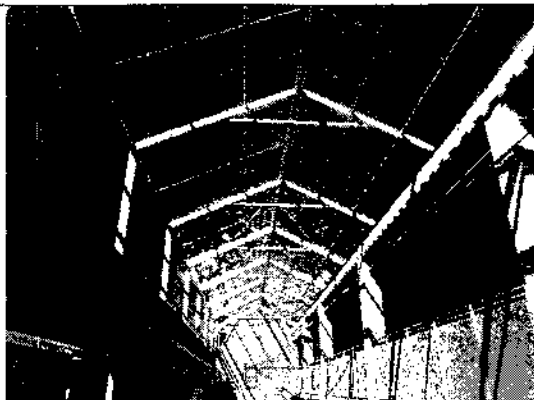
Marquesina pendiente por terminación.
