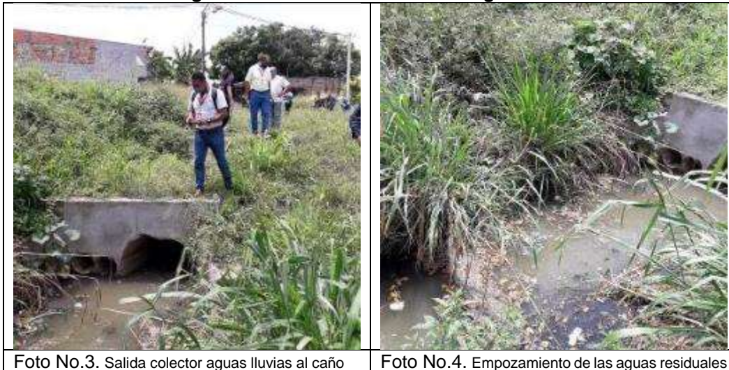
Foto No.3. Salida colector aguas lluvias al caño
