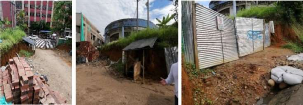
Fuente: Equipo Auditor Visita Técnica CGR octubre de 2021
