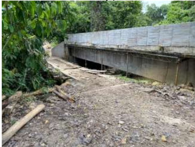
Fuente: Equipo auditor visita técnica CGR-octubre de 2021
