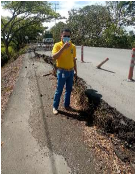
Referencia de profundidad, largo y ancho del asentamiento presentado
